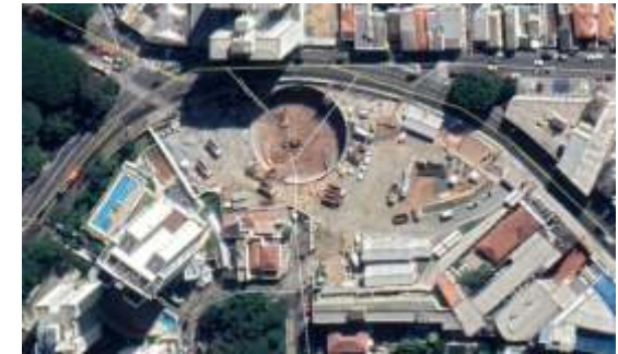
Obras da futura estação Vila Formosa
